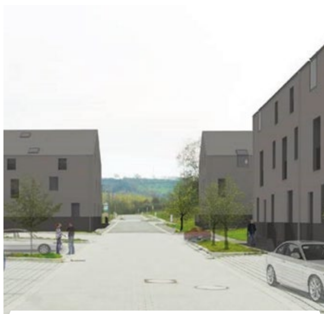
CINQ IMMEUBLES RÉSIDENTIELS À ECHTERNACH
