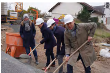
1 er coup de pelle du projet de transformation d'un ancien bâtiment de pompiers à Schieren
