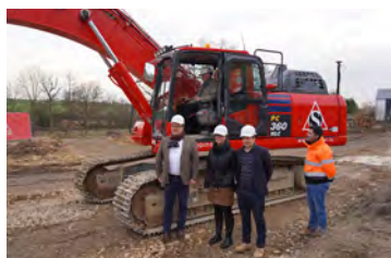
1 er coup de pelle des travaux d'infrastructures du quartier "An der Schmëtt" à Wecker
