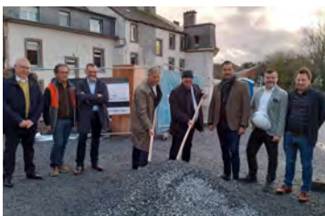
1 er coup de pelle du projet de réhabilitation de l'ancien couvent d'Useldange
